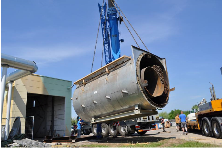
Bild 1: Im Heizkraftwerk Kamenz wird der alte ca. 80 t schwere Braunkohlebrennstaubkessel ausgebaut.
